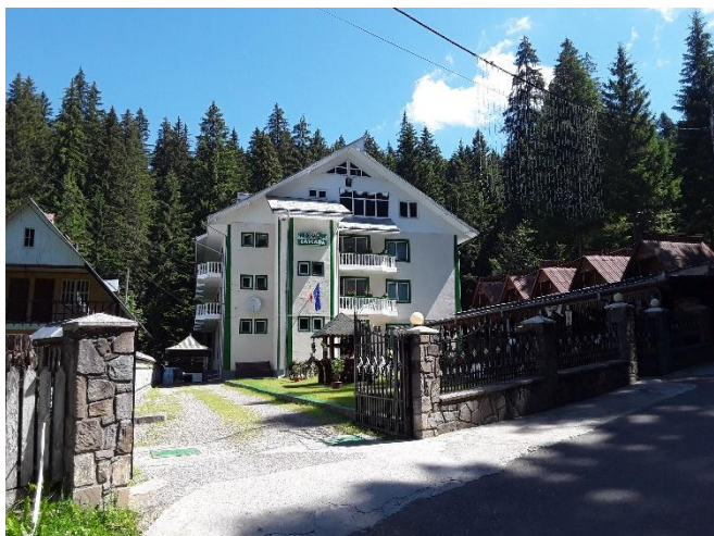
Figura 17 Hotel Cascada – 46 locuri de cazare
