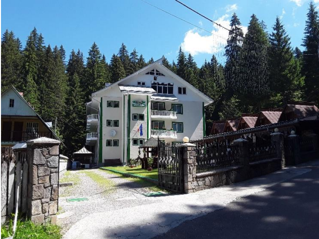
Figura 17 Hotel Cascada – 46 locuri de cazare
