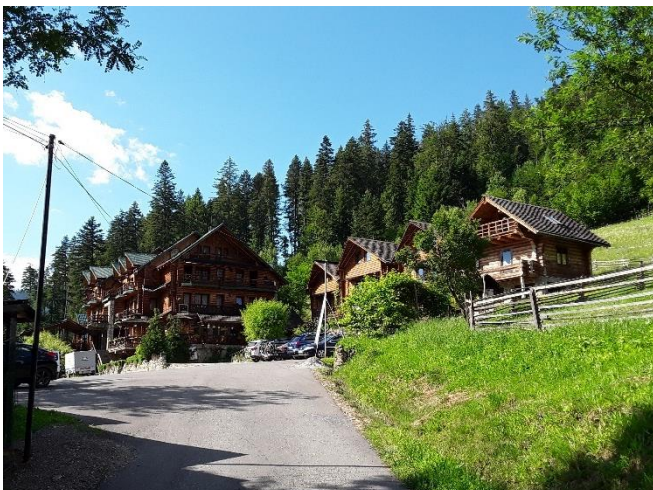
Figura 21 Complex Vânătorul - 50 locuri de cazare
