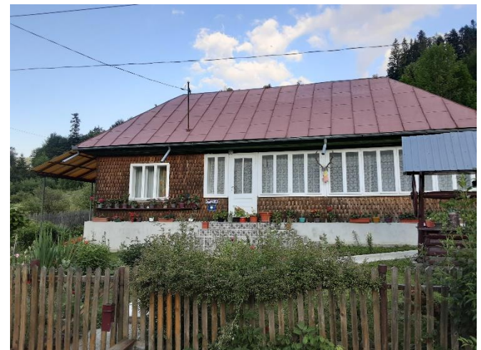
Figura 22 Casa Marica – 4 locuri de cazare
